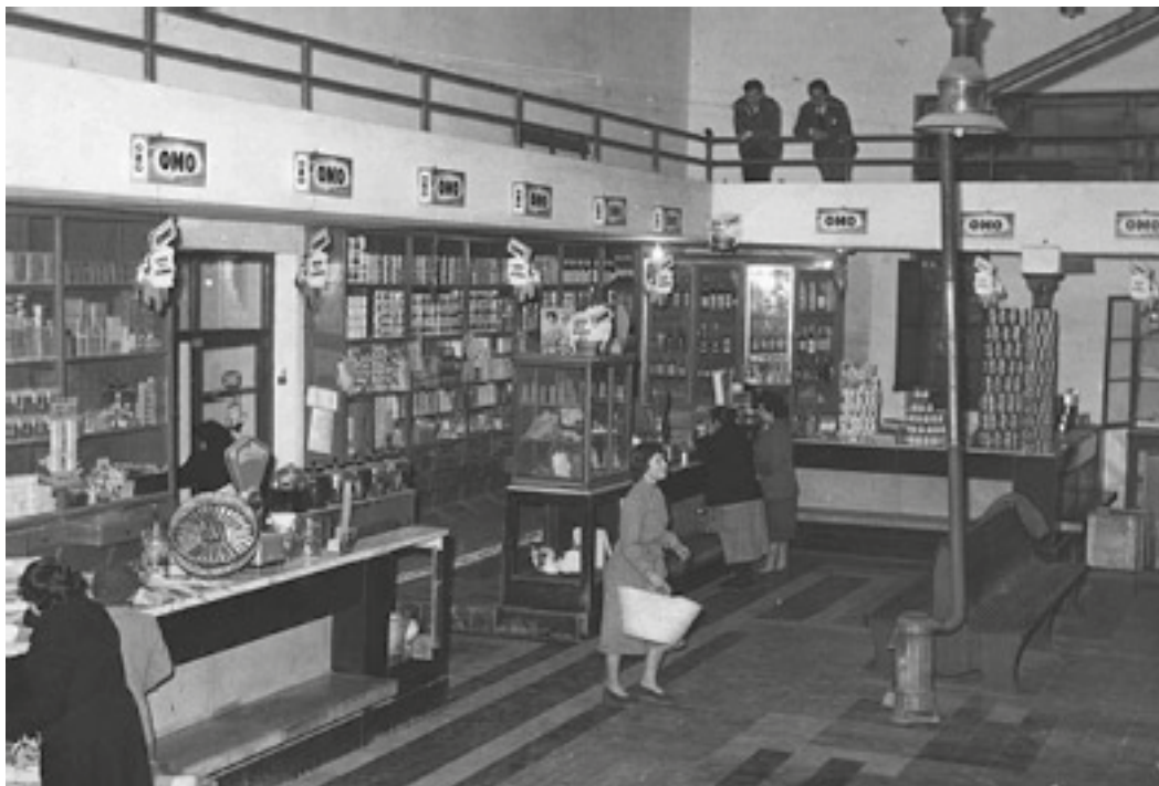
Interior de l'edifici principal de la cooperativa La Equitativa, [1954-1959].
